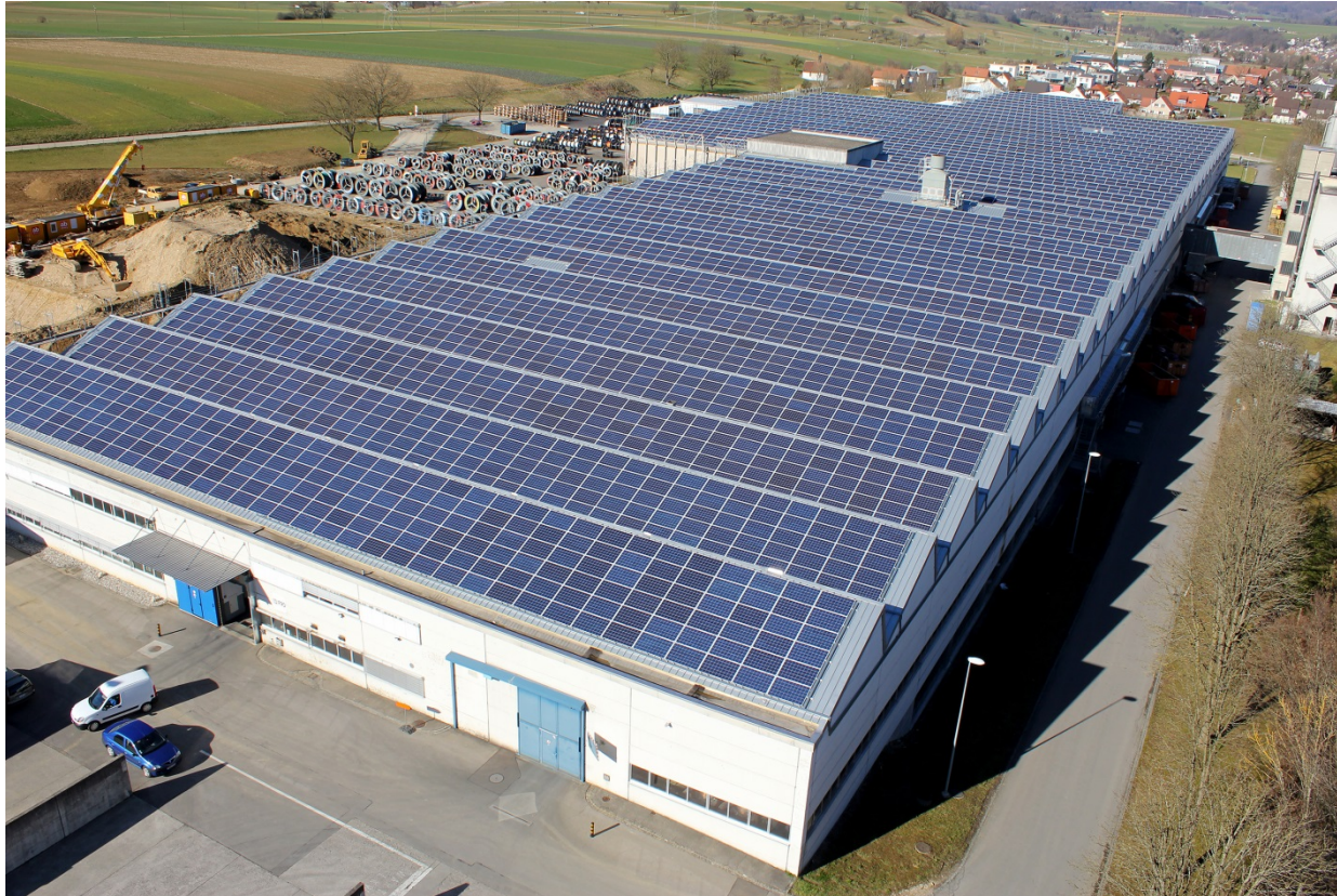
2.7 MW Anlage Von Roll Breitenbach
