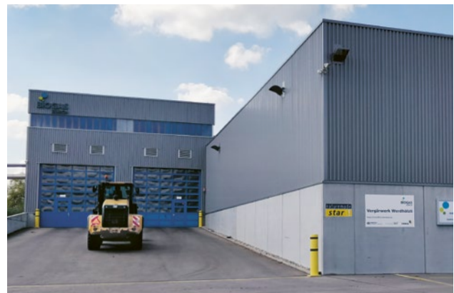
Das Vergärwerk Werdhölzli von Biogas Zürich ist seit 2013 naturemade star zertifiziert. 2018 wurde es rezertifiziert.
