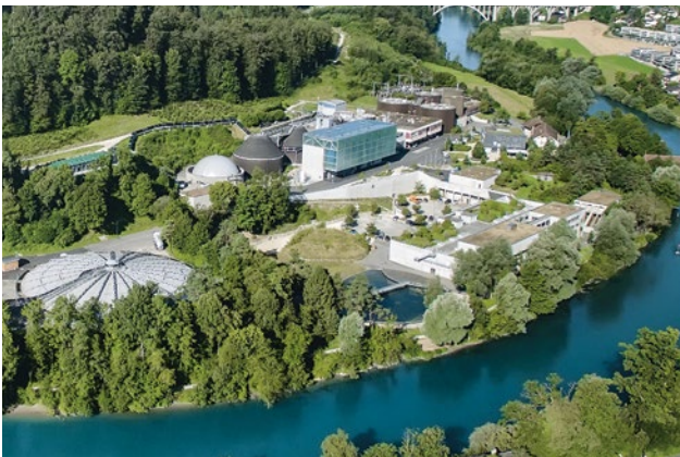
Die Berner Abwasserreinigungsanlage arabern produziert seit 2009 naturemade star Biogas. (Foto: arabern)
