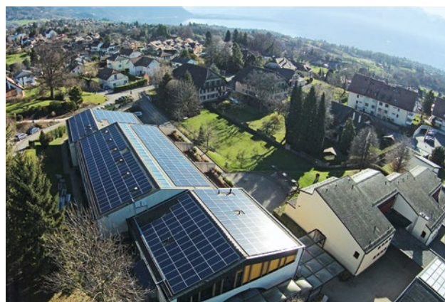
Auf dem Dach des Collège Clos Béguin in St-Légier produziert die Rochat Solaire SA in Zusammenarbeit mit der Gemeinde St-Légier seit 2015 naturemade star Strom. (Foto: Rochat Solaire SA)
