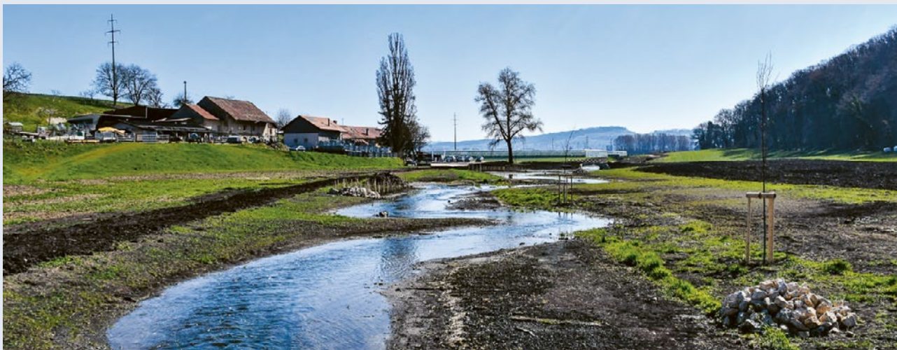
Der Bey am Fusse des Chamblon-Hügels wurde vom Beton befreit und erhielt ein viermal grösseres Bett. (Foto: Romande Energie)
