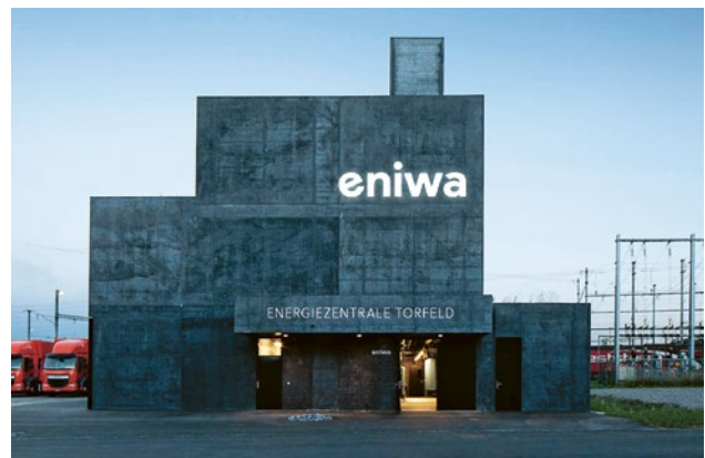
Energiezentrale Torfeld in Aarau (Foto: eniwa)
